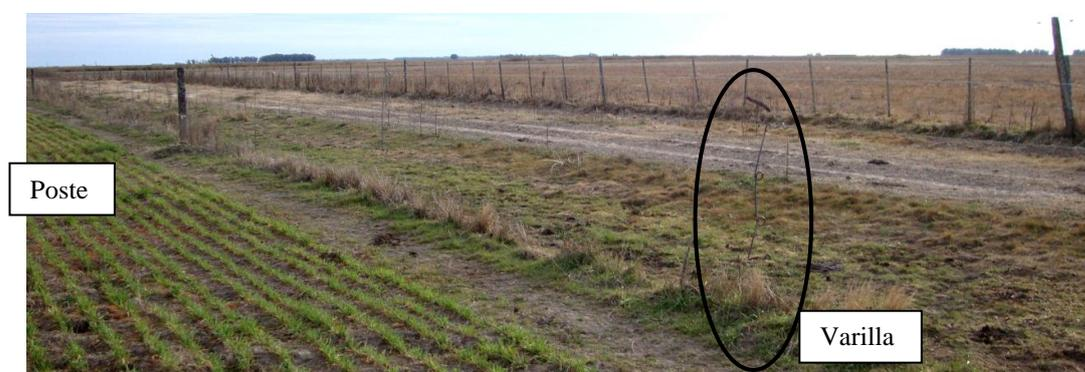
Entre los medios postes, a una distancia de 7,5 m entre una y otra, se colocan las varillas de alambre o de metal galvanizado (tienen una forma bastante particular), lo que equivaldría a 3 varillas entre los medios postes. También se pueden utilizar varillas de madera semejantes a las empleadas en los alambrados fijos o tradicionales, pero más cortas, de 0,80 m aproximadamente, dependiendo de la cantidad de hilos que tenga el alambrado.
