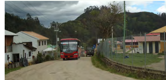
FOTO N° 2.7.2 Recorrido extra línea N° 12 sobre la vía Minas
