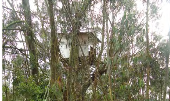
FOTO N° 4.3.3 Estado actual Mirador Casa del árbol
