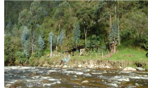
FOTO N° 2.3.7 Edificación propensa a riesgos por inundación (río Yanuncay).
