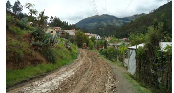
FOTO N° 2.6.4 Vía Colectora (Minas).
