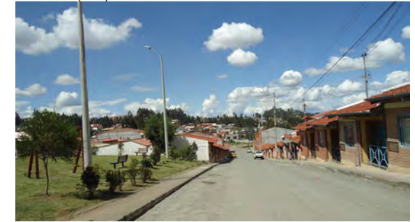
FOTO N° 2.6.5 Vía Local (S/N).
