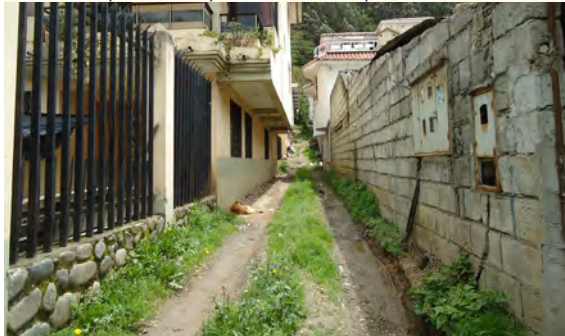
FOTO N° 3.1.2 Caminos improvisados para el acceso a predios interiores.
