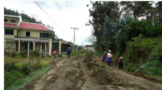
FOTO N° 2.6.2 Mantenimiento de vías en mal estado.
