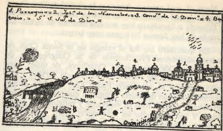
Vista de la villa de San Juan del Río, mirada de Oriente a Poniente
