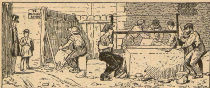
26. Canteros cortando y serrando piedra de construcción.
