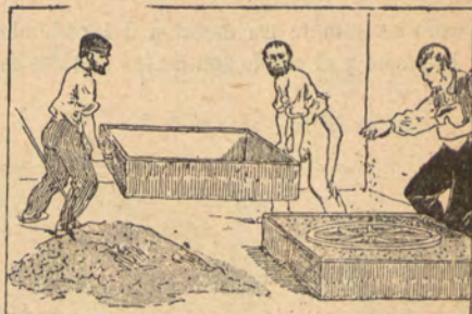
8. Obreros transportando un segundo bastidor que se coloca sobre el primero, de forma que coincidan sus bordes. El primer obrero espolvorea* el modelo con carbón.
