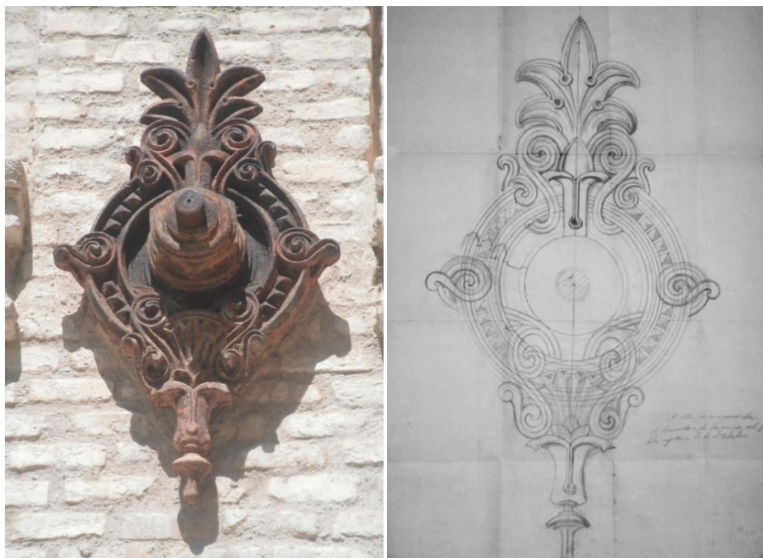
Platillos de fundición para atirantar la estructura metálica, diseño de Lidón y Barra
