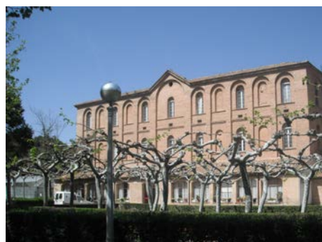
Pabellón "Dronda". Fachada sur
