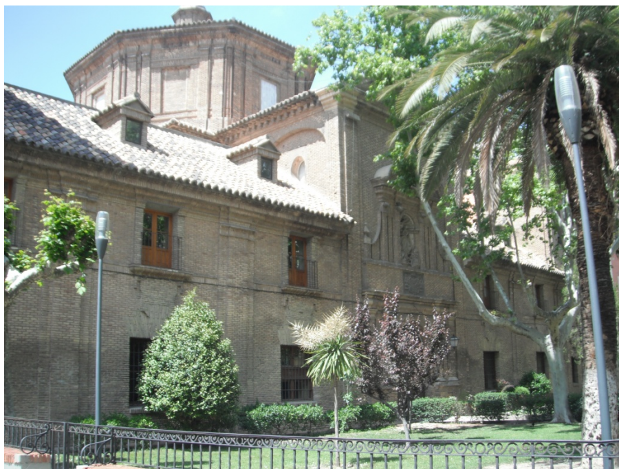
Fachada del Hospital de Convalecientes, actual Hospital de Ntra. Sra. De Gracia.
