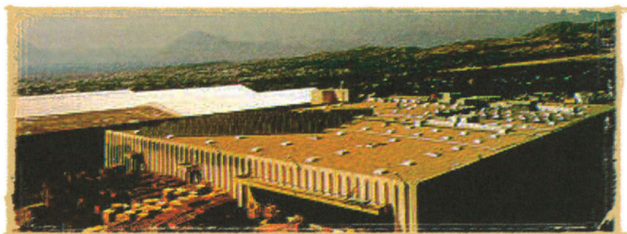
Εικόνα 116 Κεντρικό ηλιακό σύστημα στο εμφιαλωτήριο της Achaia Clauss στην Πάτρα. [48]
