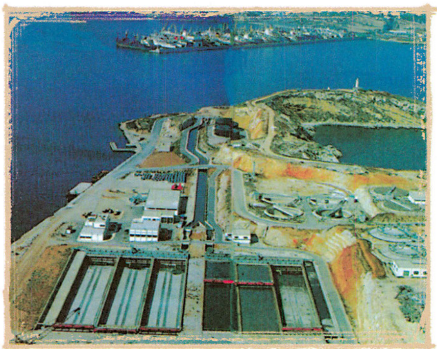
Εικόνα 90 Μεγάλο τεχνικό έργο σε παράκτια ζώνη για την επεξεργασία αστικών λυμάτων: Βιολογικός καθαρισμός Ψυτάλλειας {21}
