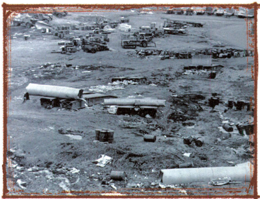
Εικόνα 68 Αυθαιρέσια και εγκατάλειψη. {26}
