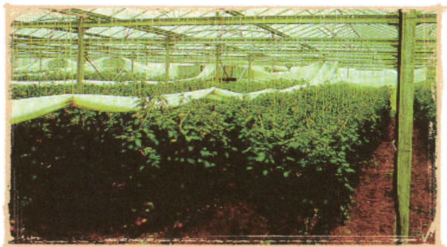
Εικόνα 123 Η γεωθερμική ενέργεια μπορεί να χρησιμοποιηθεί για τη θέρμανση θερμοκηπίων. [48]
