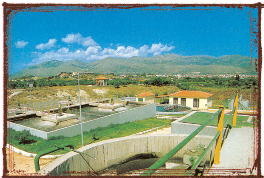
Εικόνα 98 Άποψη βιολογικού καθαρισμού
