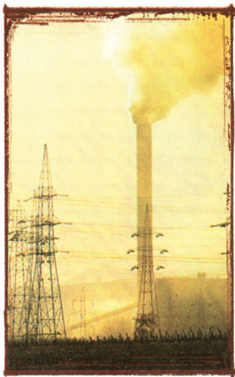
Εικόνα 60 Σταθμός παραγωγής ηλεκτρικής ενέργειας της ΔΕΗ {27}
