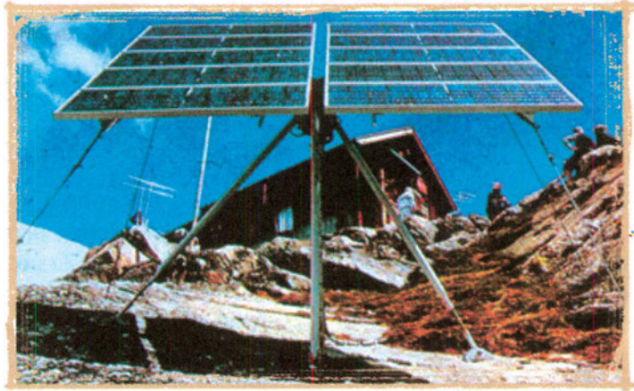
Εικόνα 61 Καθαρές τεχνολογίες παραγωγής ενέργειας: Φ/Β σύστημα Ενέργεια από τον ήλιο {27}
