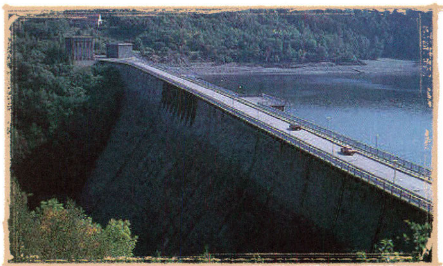
Εικόνα 28 Η κατασκευή φραγμάτων μπορεί να συνεισφέρει στην αντιμετώπιση του προβλήματος της ανεπάρκειας των υδάτινων πόρων.
