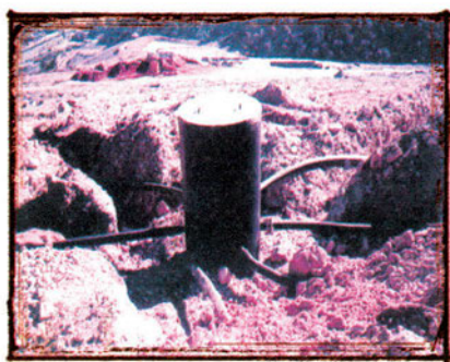
Εικόνα 105 Φρεάτιο βιοαερίου (αριστερά) και κόμβος διανομής βιοαερίου (δεξιά). [10]
