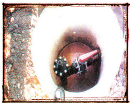
Εικόνα 105 Φρεάτιο βιοαερίου (αριστερά) και κόμβος διανομής βιοαερίου (δεξιά). [10]
