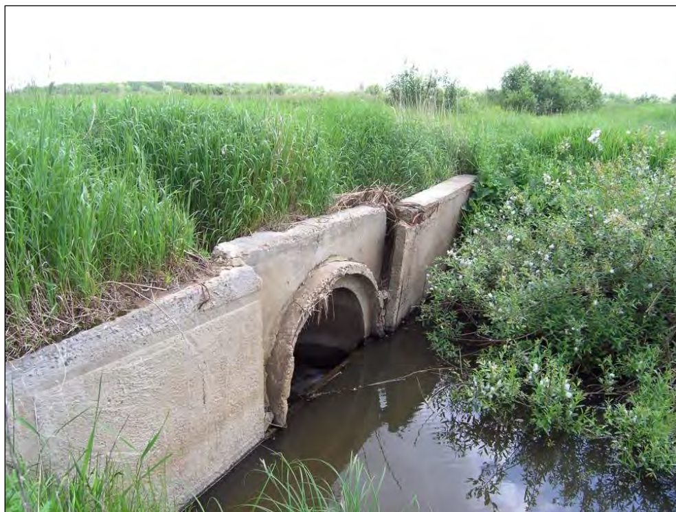
Фото 2. Деревянный щит, установленный в бетонную трубу переезда между полями, июнь 2002 г. (фото О.С. Гринченко).
