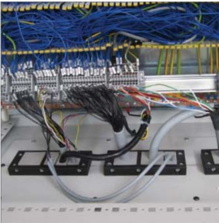
KEL 24|x - Seite 16 Einführung von teilweise vorkonfektionierten Leitungen im Schaltschrankboden zur Abdichtung des Schaltschranks nach IP54.
