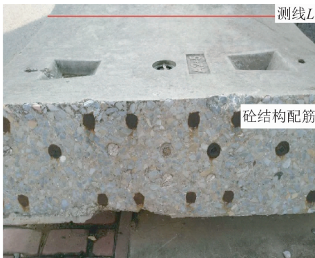
图7 试验现场布置
