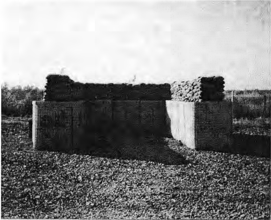
Tüzelőállás (fedezék) HESCO bástya és homokzsák felhasználásával
