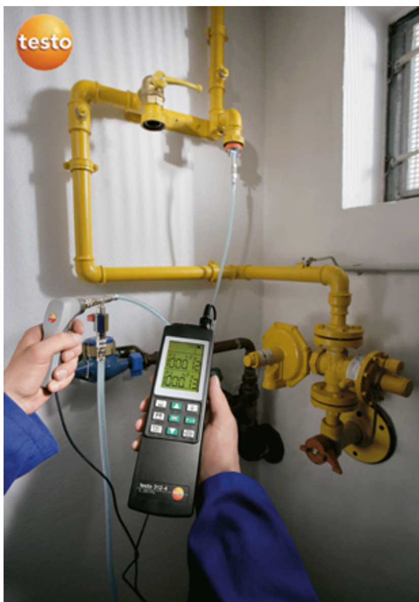
348. ábra Gázhálózat nyomáspróba TESTO 312-4 nyomáspróba műszerrel
