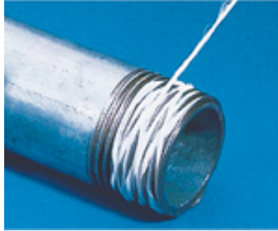
317. ábra Menettömítés feltekerés
