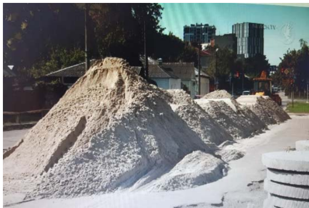
Рис. 3. – Будівництво централізованої каналізації по вул. Фіксея та по вул. Київська від вул. Гонча до вул. Північна в м. Чернігів
