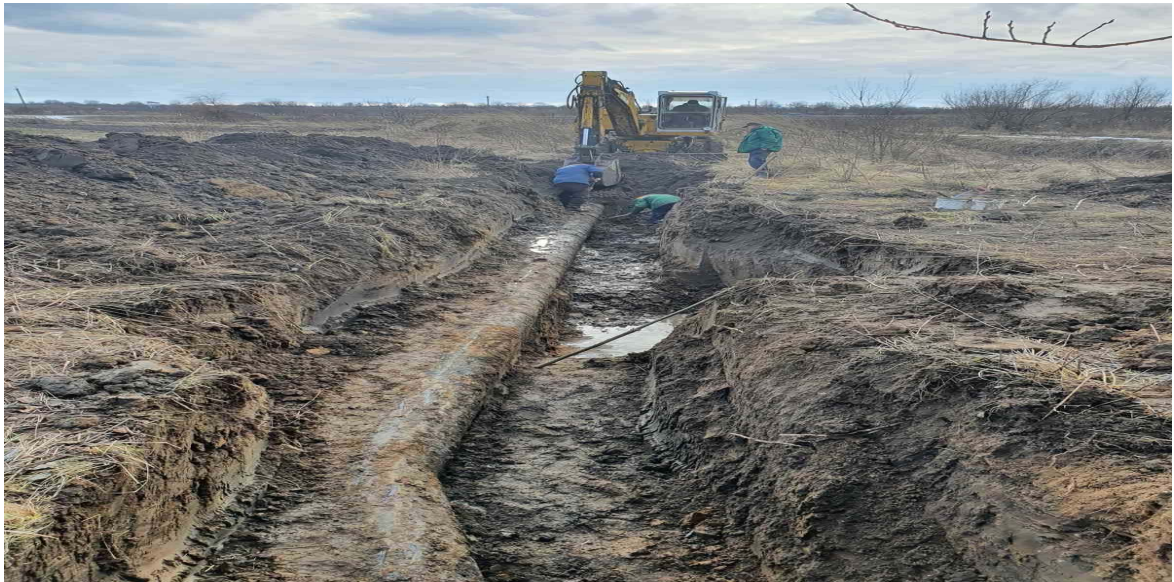
Рис. 2 – Підготовка до заміни частини водогону Будзень II – Поріччя
