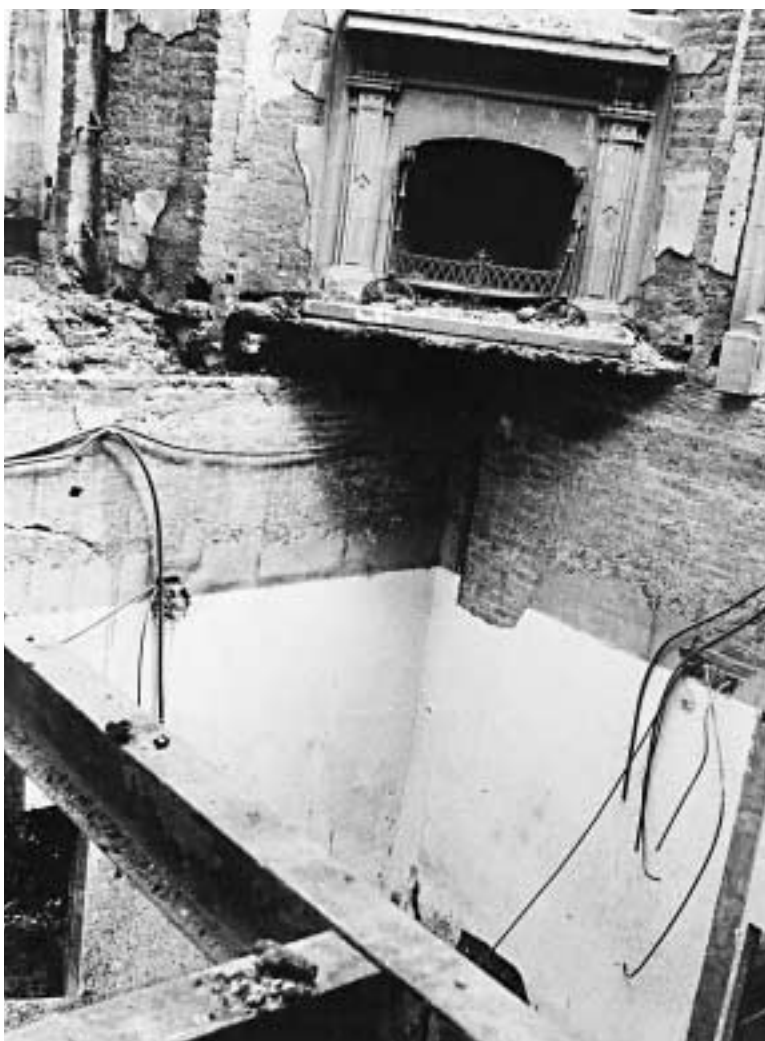
Durante el segundo ataque aéreo al Palacio de Gobierno, los proyectiles caen sobre el segundo cuerpo del edificio, entre los patios de Los cañones y Los Naranjos.
