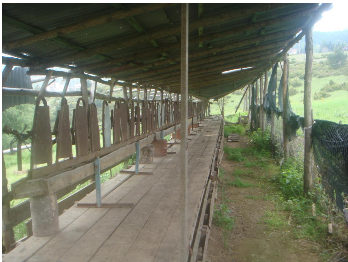
Εικ. 27. Σταβλικές εγκαταστάσεις κ. Φατούρα στο Κάτω Βέρμιο (Σέλι) Βεροίας.
