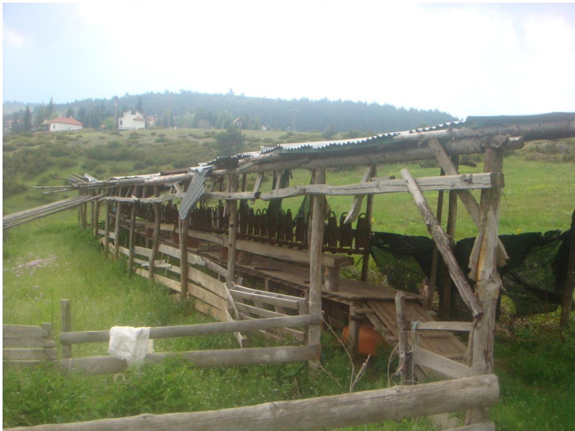
Εικ. 24. Σταβλικές εγκαταστάσεις κ. Φατούρα στο Κάτω Βέρμιο (Σέλι) Βεροίας.
