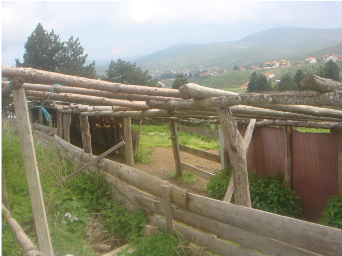
Εικ. 25. Σταβλικές εγκαταστάσεις κ. Φατούρα στο Κάτω Βέρμιο (Σέλι) Βεροίας.
