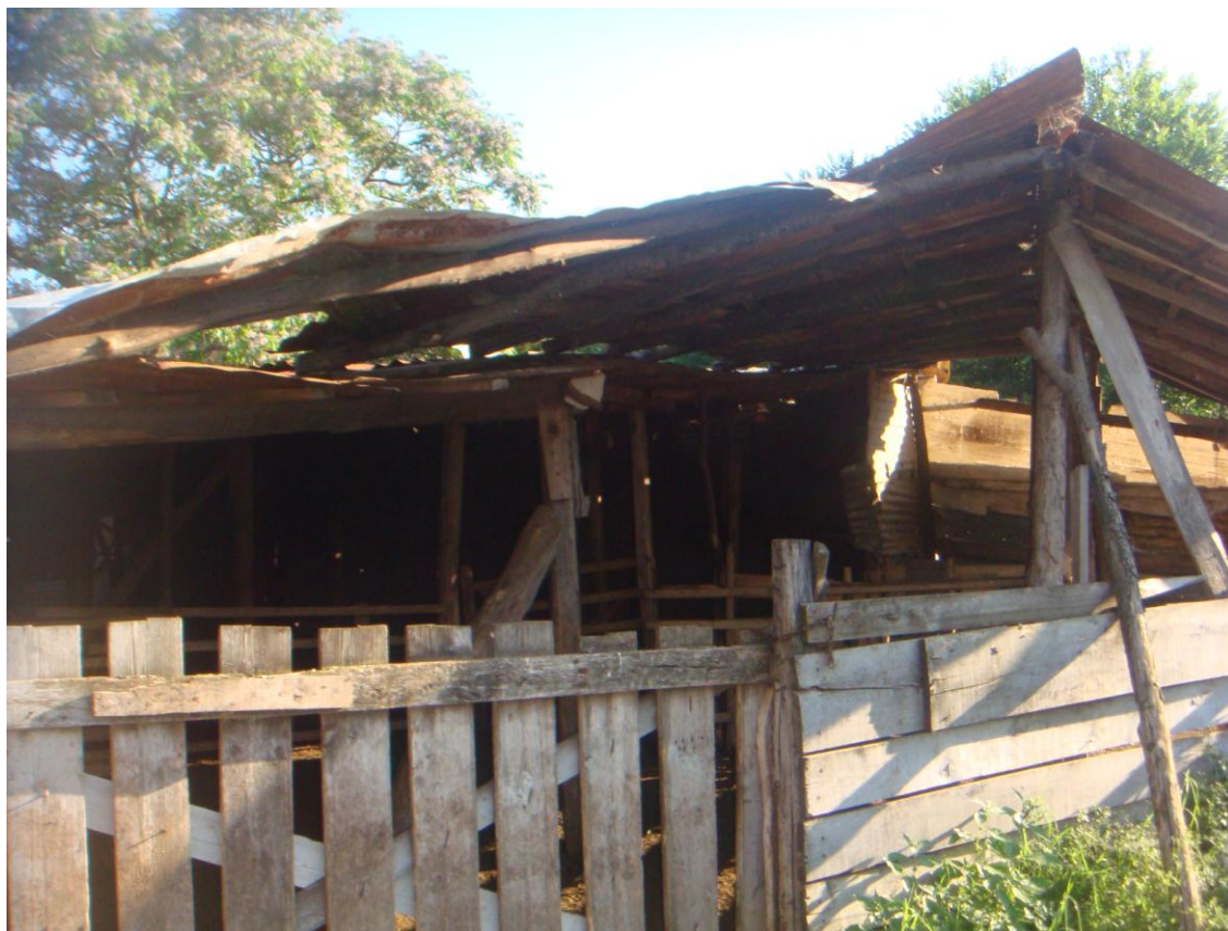
Εικ. 16. Σταβλικές εγκαταστάσεις του κ. Σερεμέτα στον Τριπόταμο Βεροίας.
