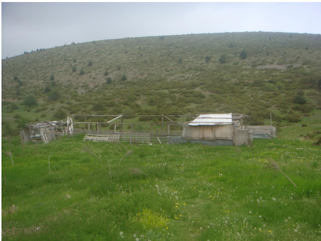
Εικ. 30. Σταβλικές εγκαταστάσεις κ. Κίρτσου στο Κάτω Βέρμιο (Σέλι) Βεροίας.
