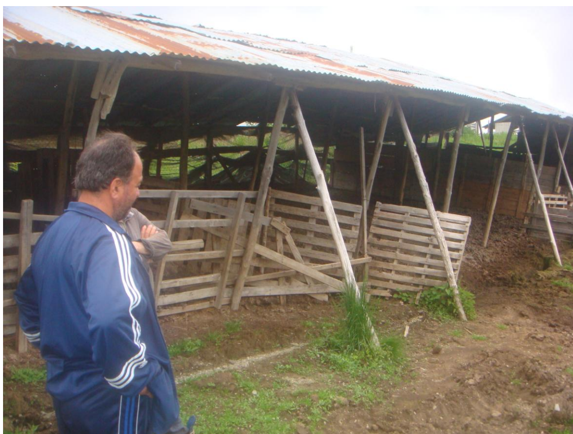
Εικ. 28. Σταβλικές εγκαταστάσεις κ. Κίρτσου στο Κάτω Βέρμιο (Σέλι) Βεροίας.
