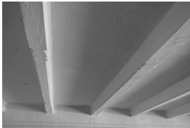
► 3. kép. Az utcai szoba födémgerendázata (fotó: Rác M.)
