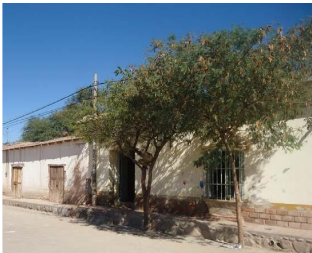
Figura 12: Fachada casa de la Magia Fuente: CEPA
