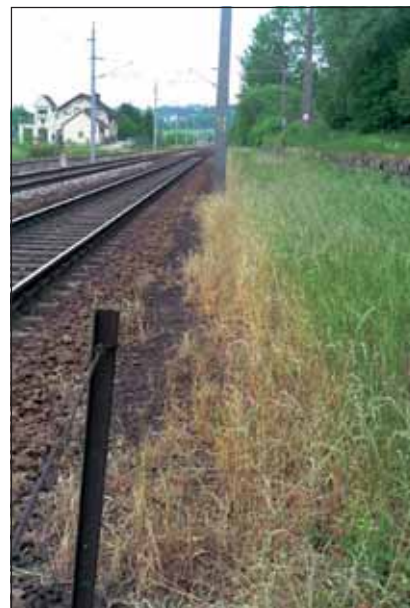
Abb. 56: Schäden durch Herbizide an den Rändern der Gleisanlagen bei Gopperding.
