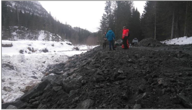
Figur 6. Ferdigstilt elveforbygging ved Dunaelva, mars 2016. Foto: Marie Uhlen Maurset, Fylkesmannen.
