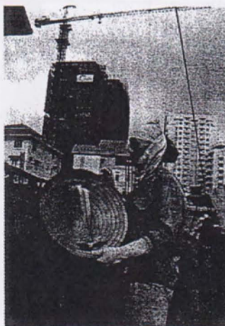
Chantier à Phu My Hung. Ce quartier d'Hô Chi Minh-Ville répond à l'idéal résidentiel des nouveaux riches.
