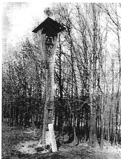
Széptölgyes (Tolna) egyszlopos, ágas, beásott, gyámmal és rövid lengőtámaszokkal megerősített harangláb 1957-ben (f csoport)
