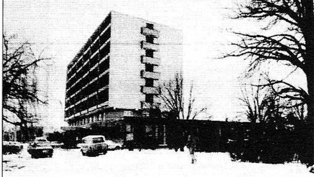
a 60-as években épült épület mai állapota
