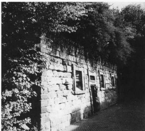
Reste der ehemaligen Festungsbauwerke: Das Klosterbollwerk neben dem ehemaligen Oberen Tor.
