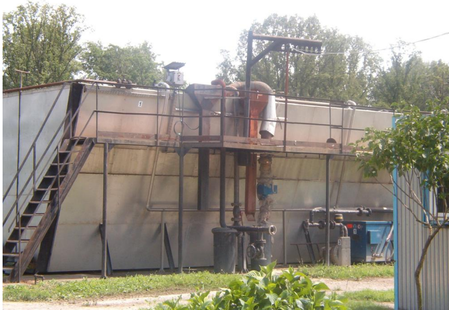
5. számú kép - Tarpai szennyvíztisztító telep (Hőszigetelés nélkül)
