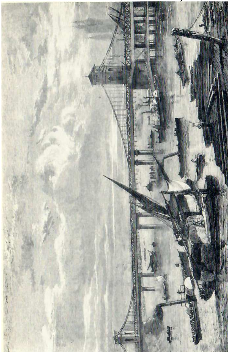
Charing-Cross Eisenbahnbrücke im Bau Stich aus dem Jahre 1863 [Br VII 32]
