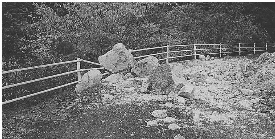
斜面崩壊による落石。
