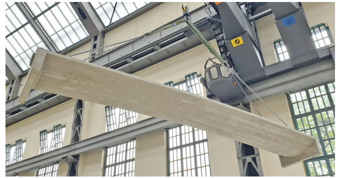
Bild 21 Hergestellte HP-Schale Constructed HP-shell
