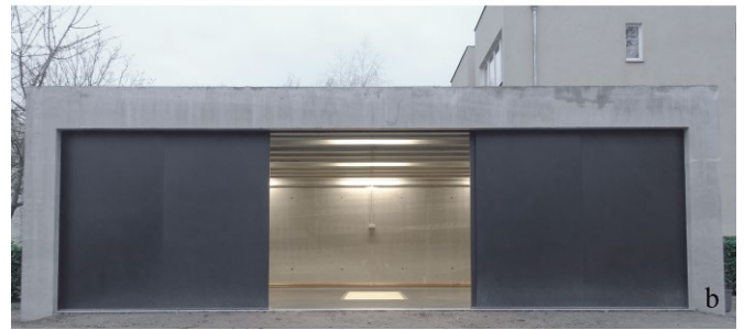
Bild 19 a. Innenansicht der gebauten Garage, b. Außenansicht der gebauten Garage a. Inner view of the constructed garage, b. Outside view of the constructed garage
