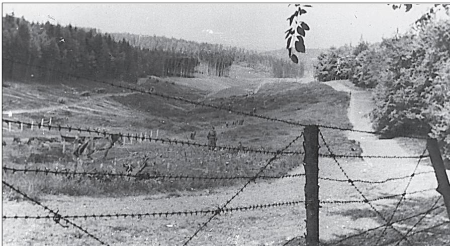
Vor nunmehr 50 Jahren wurden nach dem Bau der Berliner Mauer ab September 1961 die Grenzsperranlagen an der thüringisch/bayerischen Landesgrenze ausgebaut. Im Vordergrund der 1952 angelegte Zehnmeterstreifen, im Hintergrund wird gerade der doppelreihige Stacheldrahtzaun, zwischen den ab Sommer 1962 Minen verlegt wurden, errichtet. Unsere historische Aufnahme entstand zwischen Schwanhausen/Ermershausen und Schweickershausen/Hellingen.
