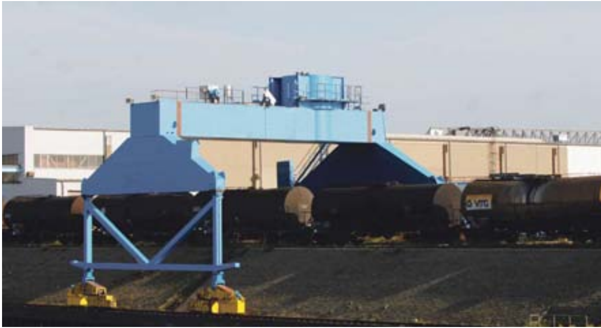
Schon jetzt lässt sich sehr gut erkennen, was für ein Riese Kran „21a“ einmal wird.
