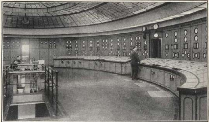
A 30 KV-os kapcsolóház vezénylőterme
