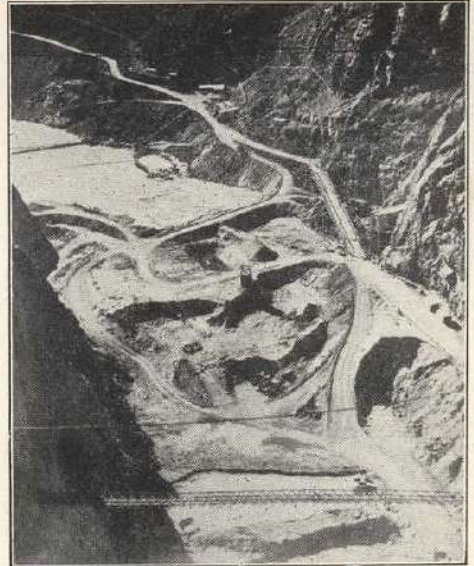
A Coloradó-folyót felduzzasztó Boulder-gát (Hoover Dam). A folyó medrének cement-alapja az építkezés első szakaszában
