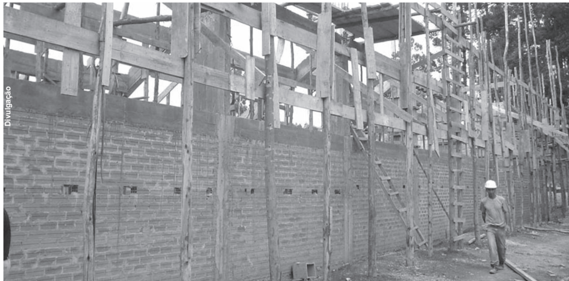
GINÁSIO, em construção próximo a escola Guita Federmann, custará quase R$ 2 milhões e terá quase 3 mil m²
