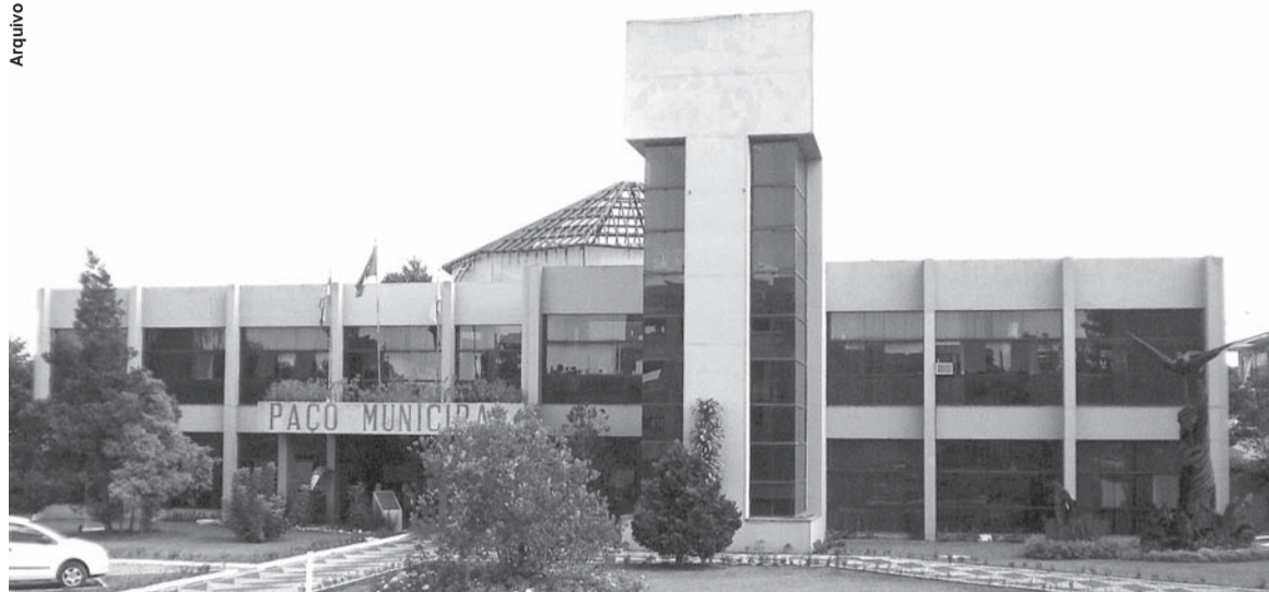
DINHEIRO recebido pela prefeitura está financiando obras de infraestrutura em vários pontos do município
