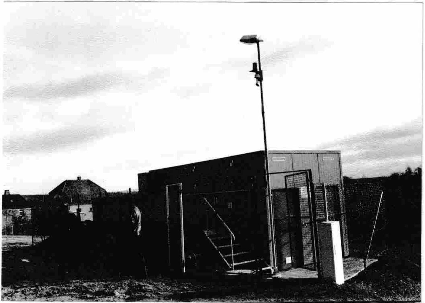
Kläranlage am Hummelsberg
