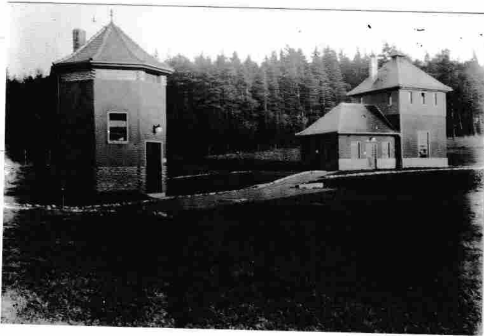
Wasserwerk mit Pumpstation Tiefenbrunnen
