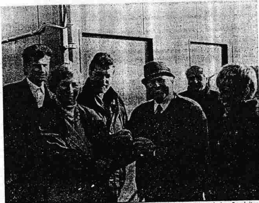
Petra Räuber vom Hersteller WKS Klärsysteme Dresden übergab am Mittwoch dem Reudnitzer Bürgermeister Gerwin Bölke die Schlüssel für die Kläranlage „Am Hummelsberge“. Den künftigen Betreiber, den Zweckverband TAWEG, vertrat Fred Brockmann (Mitte)
