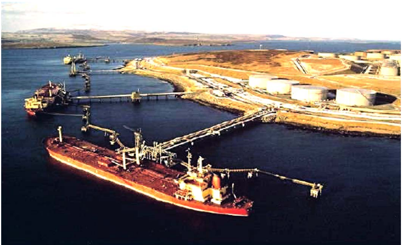
Sullom Voe Terminal
