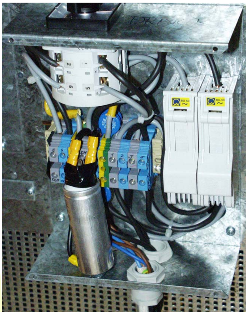
SAI de 10kW Chloride
