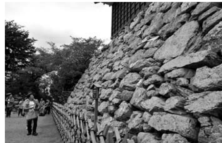
浜松城石垣(浜松市) 堀尾吉晴が近江から石積み職人(穴太衆)を呼び寄せ築いた石垣と伝わる。野面牛蒡積と呼ばれる手法である。
