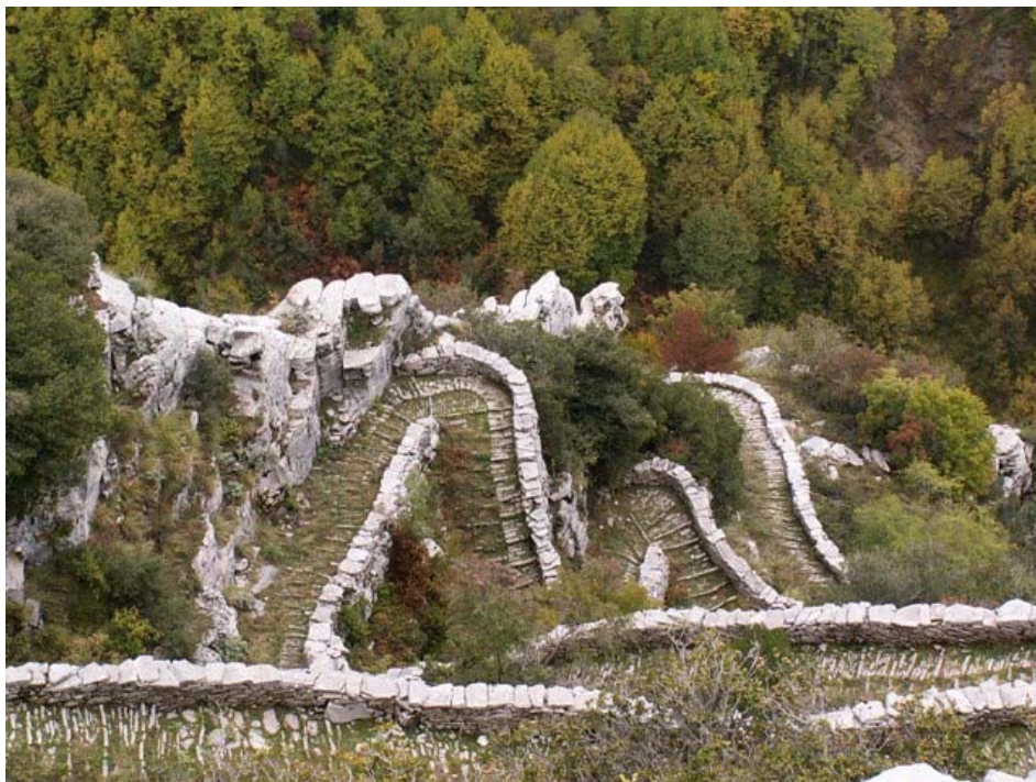
Εικόνα 5: Άποψη της Σκάλας του Βραδέτου, όπου φαίνεται η θαυμάσια αρχιτεκτονική της.
