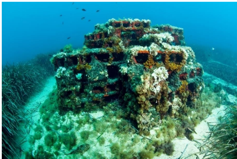
Εικόνα 2: Τεχνητός ύφαλος τοποθετημένος στο Μονακό, για προστασία λειμώνων φανερογάμων. ( https://www.sfportresilience.com/artificial-reef )
