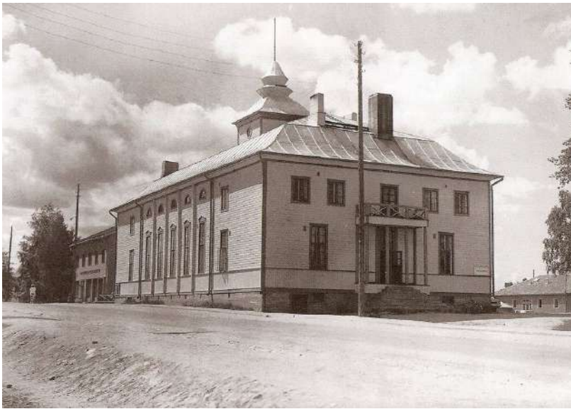
Kuva 8: Korpilinna oli monipuolinen talo Kuhmossa vuosina 1928-1970. Korpilinna sijaitsi Kuhmon keskustassa ja rakennettiin alunperin suojeluskuntataloksi. 2020
