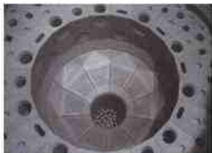
炉心のグラファイト材装着
