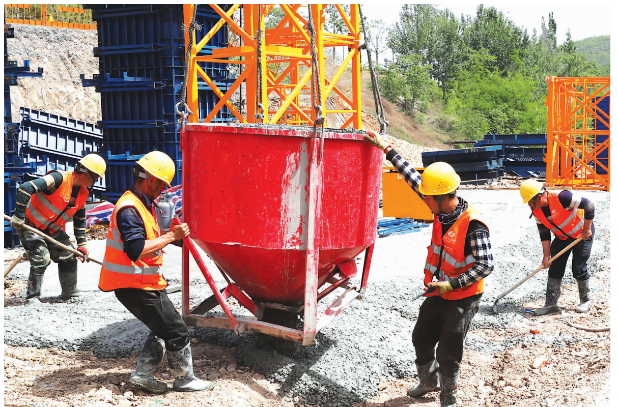
“五一”假期,由河北交投路桥集团承建、石太高速改扩建五分部建设的大龙窝大桥项目3号桥7号承台正在进行场地路面硬化施工。据了解,该项目桩基共42根,现已完成36根,施工进度顺利。据了解,5月11日起,青银高速公路(G20)石太枢纽互通至平赞枢纽互通改扩建施工实施交通分流,项目拉开架势大干快上,确保顺利完成上半年“双过半”任务。樊连贵 侯彦翠 摄影报道
