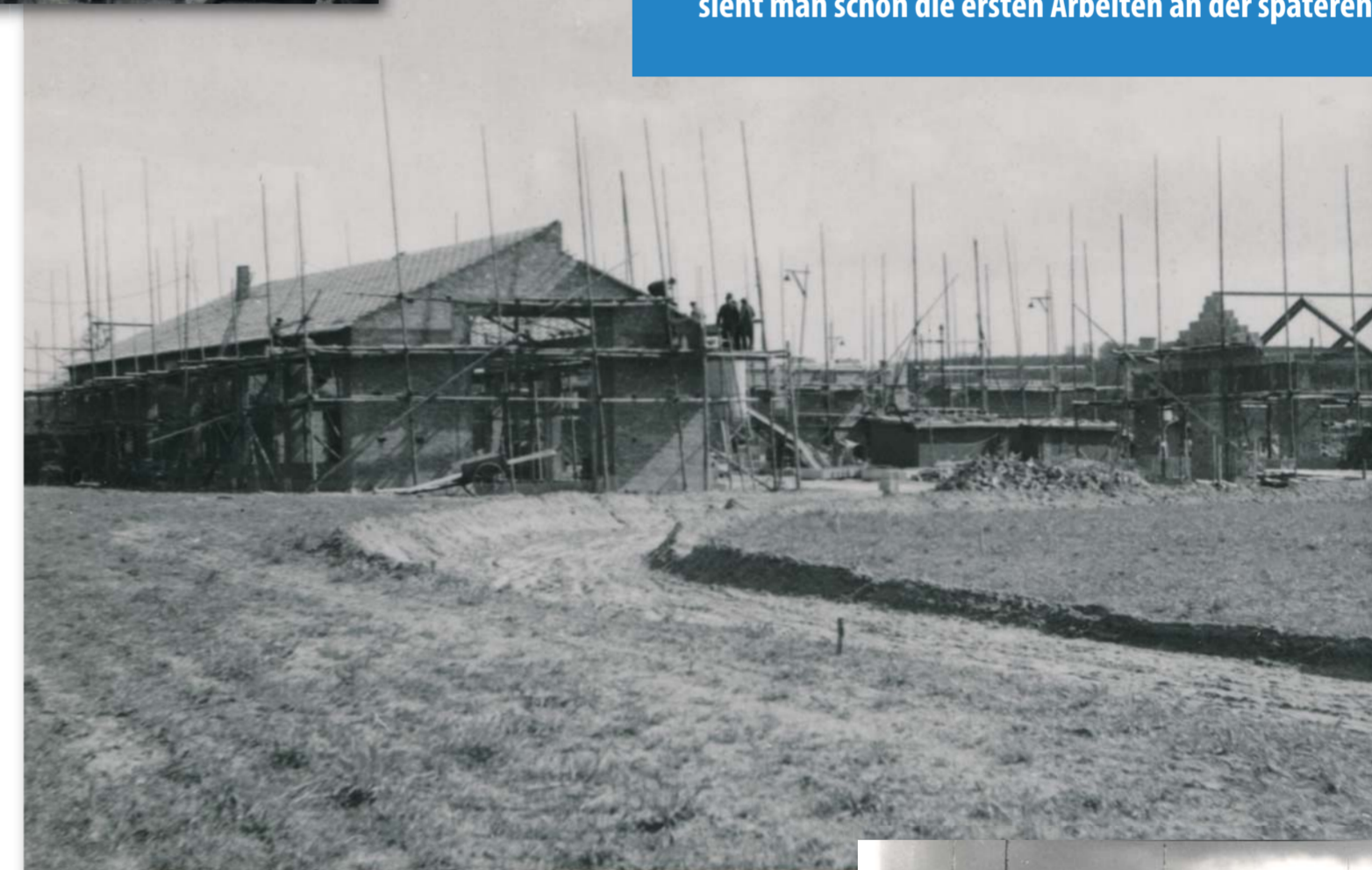
Blick auf die Baustelle. Auf den Holzgerüsten stehen Dachdecker, die gerade das Dach decken. Im Vordergrund sieht man schon die ersten Arbeiten an der späteren Prüfbahn.
