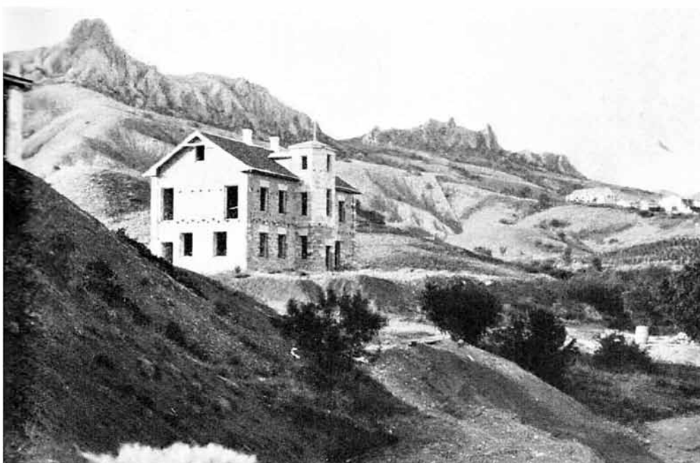
Рис. 4. Домъ для работающихъ на станціи.
