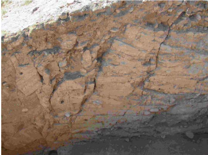
6. ábra. Döngölt fal régészeti ásatás 2,5 m mély árkában (Tosszor-erőd, az Isszik-kul déli partján): A rétegzést az ásató régész karcai emelik ki. Három törés harántolja a falat. Részletes leírása: Korzhenkov et al. 2016). Fotó: Kázmér M. x1246.
