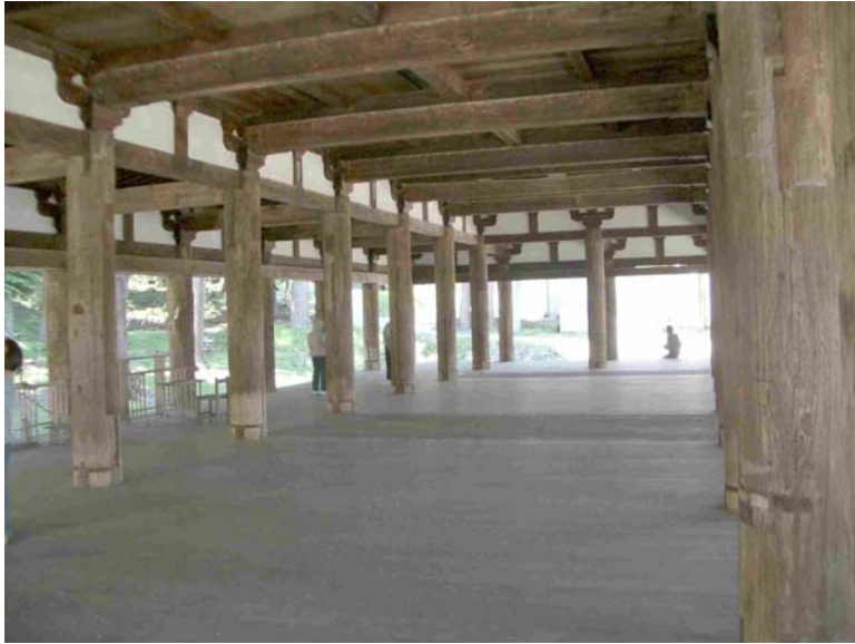
8. ábra. Vastag függőleges oszlopok és vízszintes tartók alkotnak stabil, háromdimenziós faszervezetet, amely a nehéz cseréptetőt tartja ebben a buddhista szentélyben. Wakamacu prefektúra, Japán. Fotó Kázmér M., #0700.)
