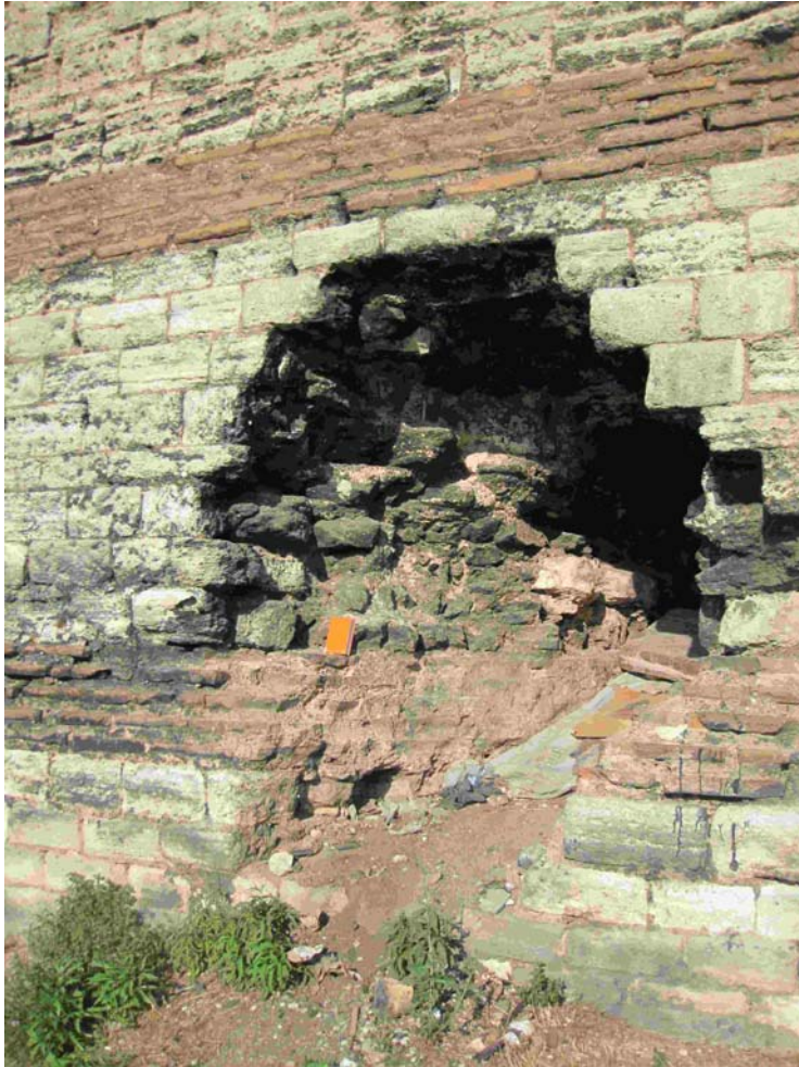
14. ábra. A kőrétegek közé rakott téglasorok az öt méter vastag fal teljes szélességét átharántolják. Theodosius császár városfala, Isztambul, 5. század. Fotó: Kázmér M., #0283.
