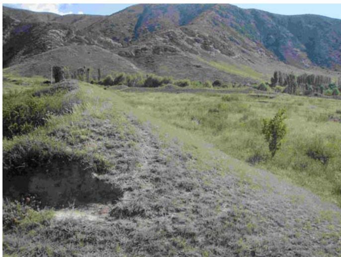
5. ábra. A középkori Kamenka-erőd északnyugati fala. Az előtérben a a döngölt falat keresztező ásatási árok. A háttérben az 1911-es földrengés során 4 m balos elvetést szenvedett falrészlet. Fotó Kázmér M., #1178. 2
