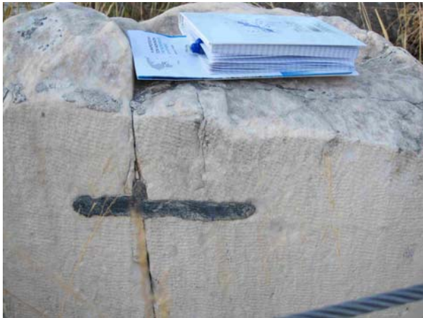
16. ábra. Ólomba ágyazott vaskapcsok kötik össze a szomszédos kőtömböket. Erechtheion, Athén, Görögország, kr.e. 5. század. Fotó: Kázmér M., #1171.
