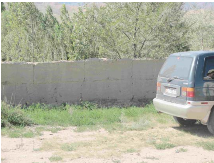
7. ábra. Vert földből készült útmenti korlát Kirgíziában. Két fa zsalutábla közé homokos agyagot döngöltek. Fotó Kázmér M., #1249.
