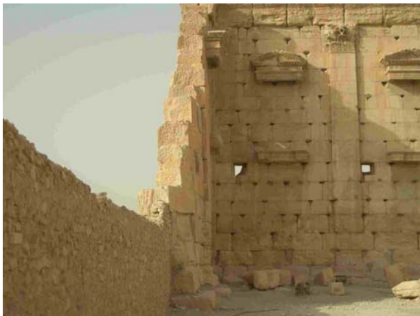
17. ábra. A szomszédos kőtömböket ólomba ágyazott vaskapcsokkal kötötték össze. Későbbi századokban az ólmot szisztematikusán 'újrahasznosították': a tömbök sarkán a bevésés ennek tanújele. Baál-szentély, Palmüra, Szíria, Kr.u. 1. század. Fotó: Kázmér M., #4245.
