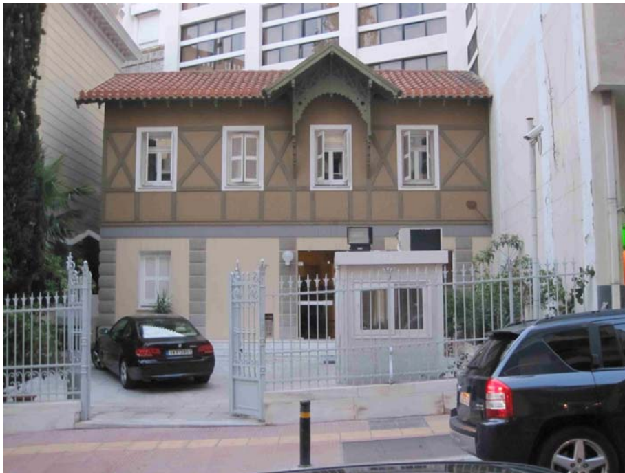
12. ábra. Favázás épület Athénban. Független oszlopok és vízszintes tartók szerkezetét X-alakú keresztmetszések stabilizálják. A faanyag köze téglával vagy vályoggal van kitöltve. Fotó Kázmér, M. #1399.
