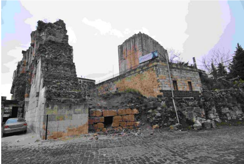
22. ábra. Safita 11. századi várának romjai. Jól látható a két, vékony réteg zsalukő közé öntött, több méter vastag római beton. Fotó: Major Balázs, #DSC_9559.
