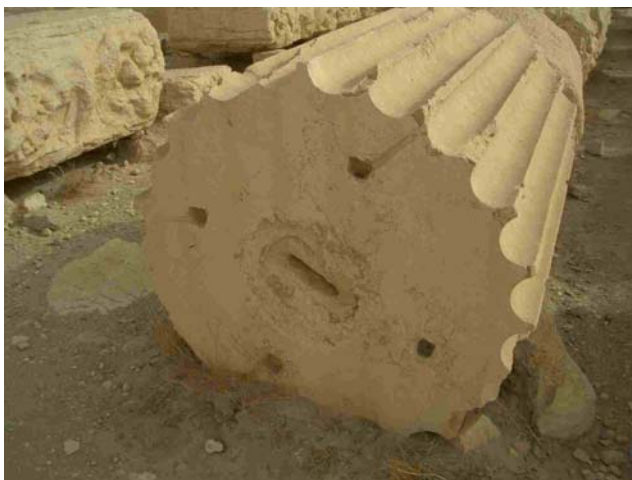
18. ábra. Az oszloptagok végébe ágyazott acélcsapok akadályozták meg az elmozdulást. A korrózió megakadályozására ólommal öntötték körül a csapokat: jól láthatók az öntőcsatornák. Baál-szentély, Palmüra, Szíria. Kr.u. 1. század. Fotó: Kázmér M., #4255.)
