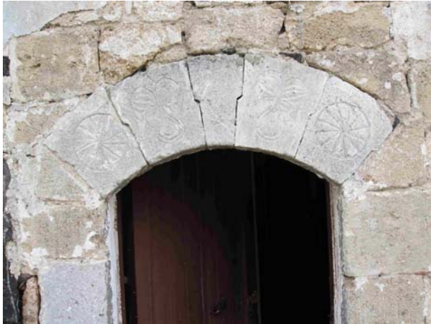
20. ábra. A reteszelt illeszkedésű kőtömbök nem mozdulnak el egymáshoz képest a fallal párhuzamos rezgések esetén: a zárókő nem tud lezuhanni, és nem omlik össze az ív. Ottomán épület Margat várában, Baniasz, Szíria. Fotó: Kázmér M. #1416.
