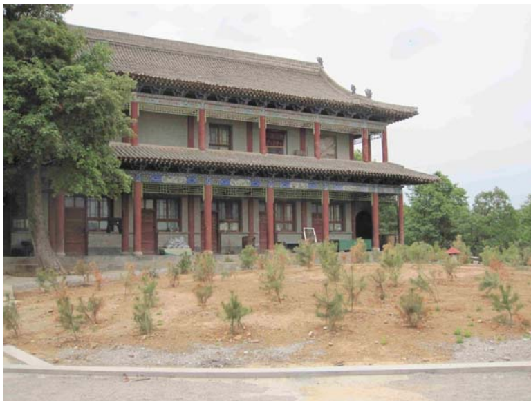
9. ábra. Favázás épület, téglá kitöltéssel. Buddhista kolostor lakóépülete, Tiansui, Ganszu, Kína. Ez a szerkezet extrém módon rengésálló: a csapolással összeerősített függőleges oszlopok és vízszintes tartók a rengés során is megőrzik geometriájukat; esetleg a téglák kipotyoghatnak a közeikből. Fotó Kázmér M., #3068.
