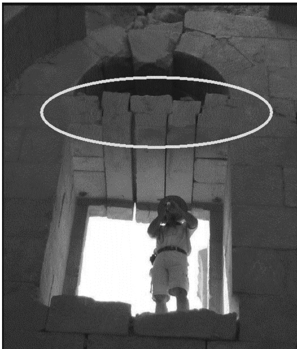
21. ábra. Ablak szemöldökkövének szerepét betöltő lapos ív reteszelt illeszkedésű kőtömbökből (bekarikázva): Fölötte a zárókő lezökkent, míg a lapos ív tömbjei könnyedén fölvtették a tágulást. Hatodik századi praetorium Halabiyyában. Ez az ókori Zenobia az Eufrátesz mentén, Szíriában). Tombor Balázs fényképe.
