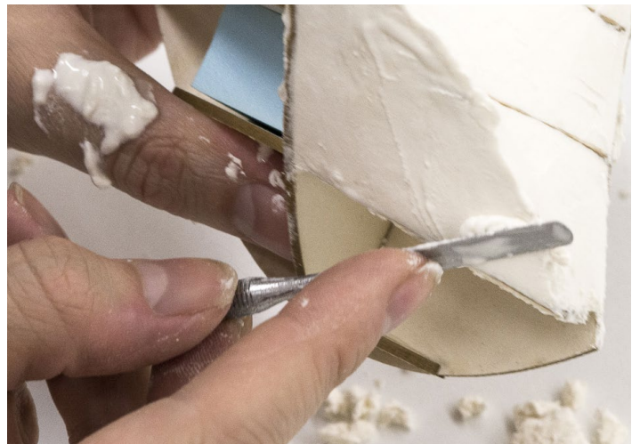
Abziehen von verdünntem efa plast light mit einem Spatel
