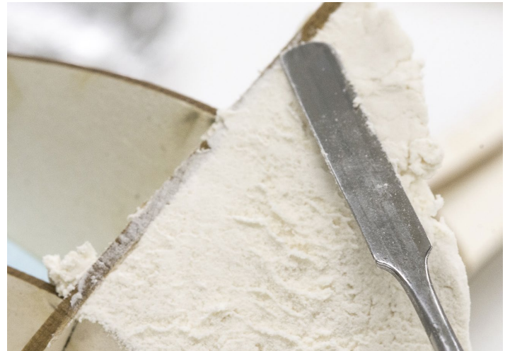
Abziehen von efa plast light mit einem Spatel
