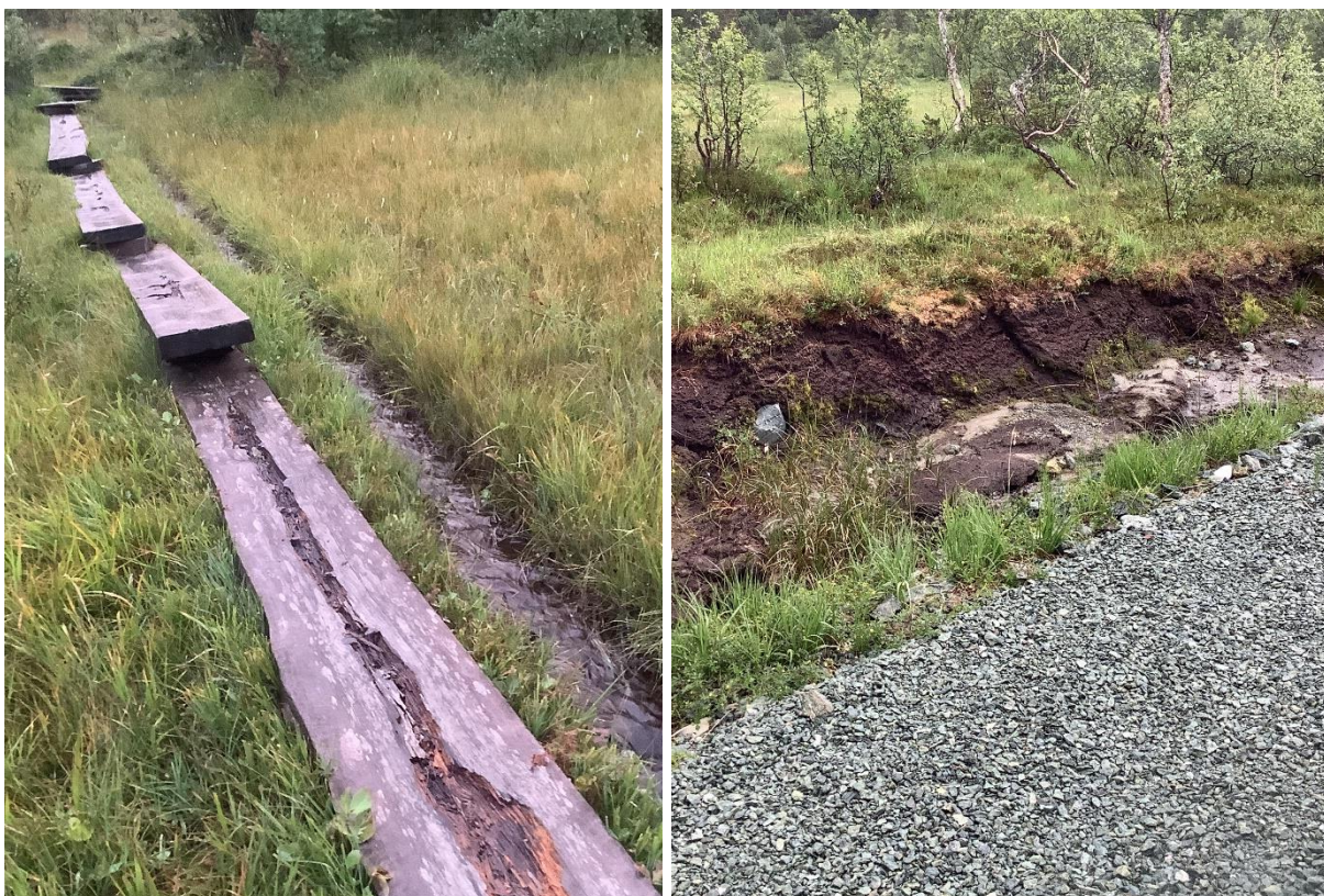
Figur 18. Til slutt et par bilder fra like utenfor reservatgrensene. Stien (t.v.) har klopper gjennom myr som har liten hensikt. Når det regner er disse såpeglatte, noe som resulterer i at publikum trækker sin egen sti ved siden av kloppene. Her har det nylig regna, og vann renner i stien. Veien (t.h.) ligger noen få meter nord for reservatet, men slik til i terrenget slik at grøftene ikke påvirker myrene innenfor reservatet. Bygging av slike veier i intakte myrsystemer er likevel uheldig da det både drenerer myrsystemene og fører til karbonutslipp. Foto: Solfrid Helene Lien Langmo.
