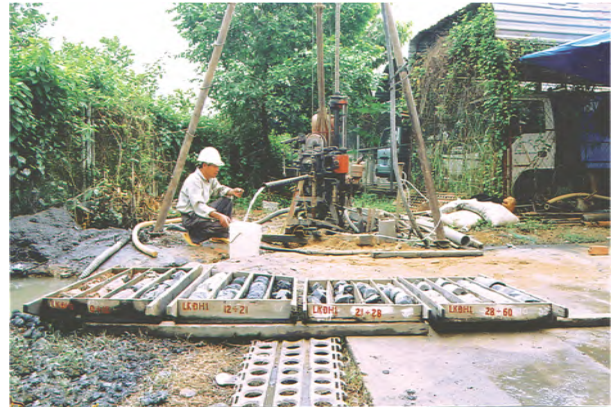
Khoan điều tra kết hợp khai thác nước tại trụ sở UBND huyện Đa Huoai (năm 2006)
