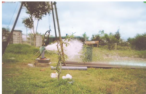
Bơm thổi rửa bằng máy nén khí lỗ khoan DL5 - thị trấn Thạnh Mỹ, huyện Đơn Dương
