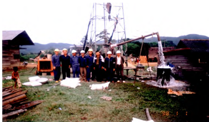
Thí nghiệm hút nước bằng máy ép hơi phục vụ tính toán trữ lượng
