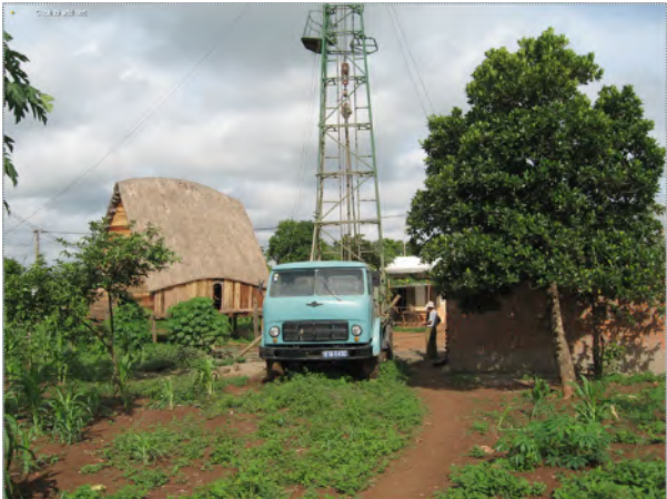
Sử dụng máy khoan URB nghiên cứu địa tầng địa chất thủy văn
