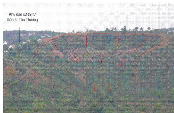
Nứt sụt đất trên vỏ phong hóa bazan thôn 3, Tân Thượng, Di Linh
