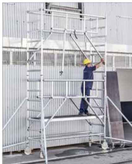
2. Geländer an Sprossen befestigen
