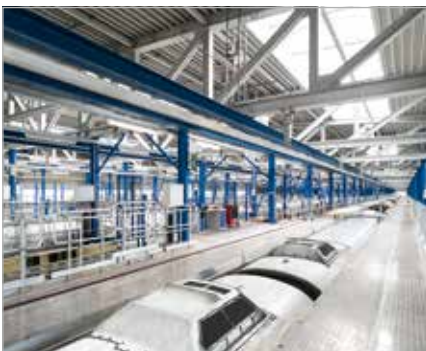
Dacharbeitsstand mit ca. 1.300 m Länge für 3 Gleise
