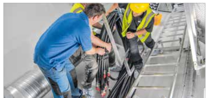
Supervising beim Einbau
