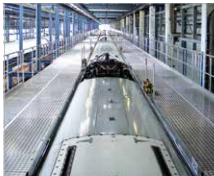
Dacharbeitsstand mit ca. 920 m Länge für ICE-Wartung
