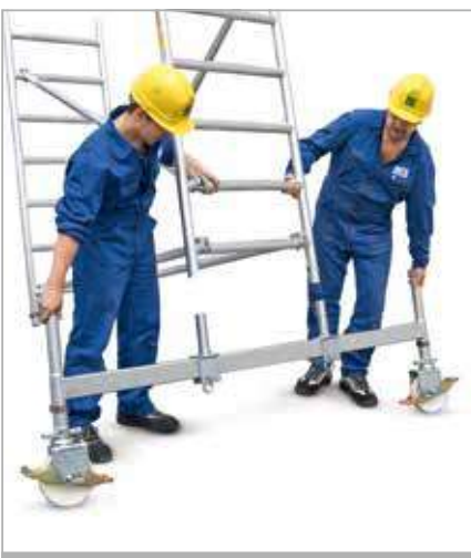
Aufsteckrahmen auf die Fahrbalken aufsetzen ...
