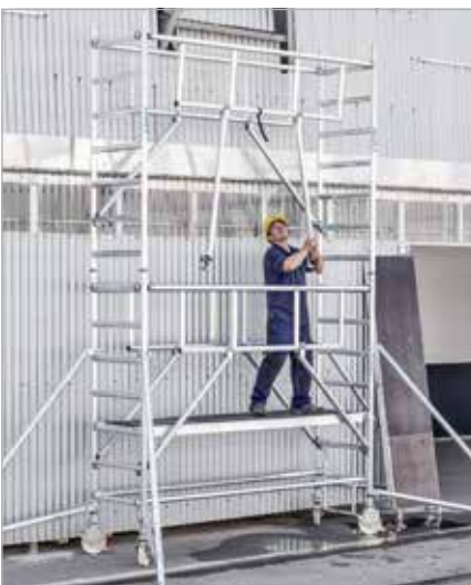
1. Vorlaufendes Geländer einsetzen
