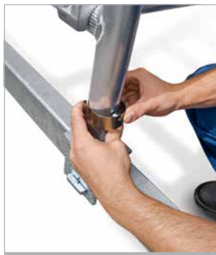
... und mit Federclips befestigen
