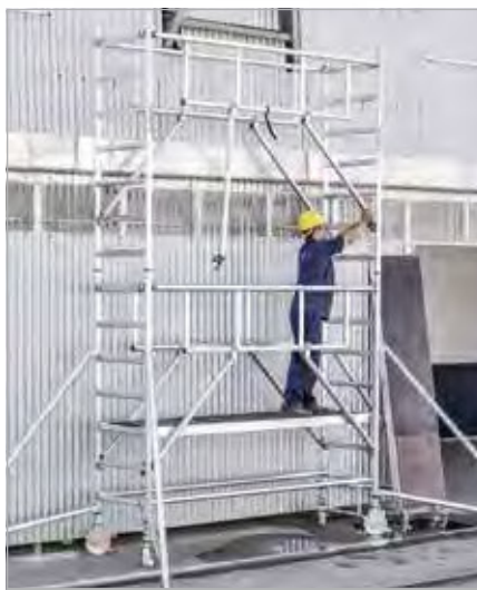
2. Geländer an Sprossen befestigen
