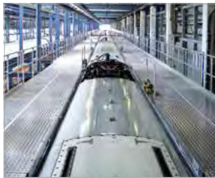
Dacharbeitsstand mit ca. 920 m Länge für ICE-Wartung
