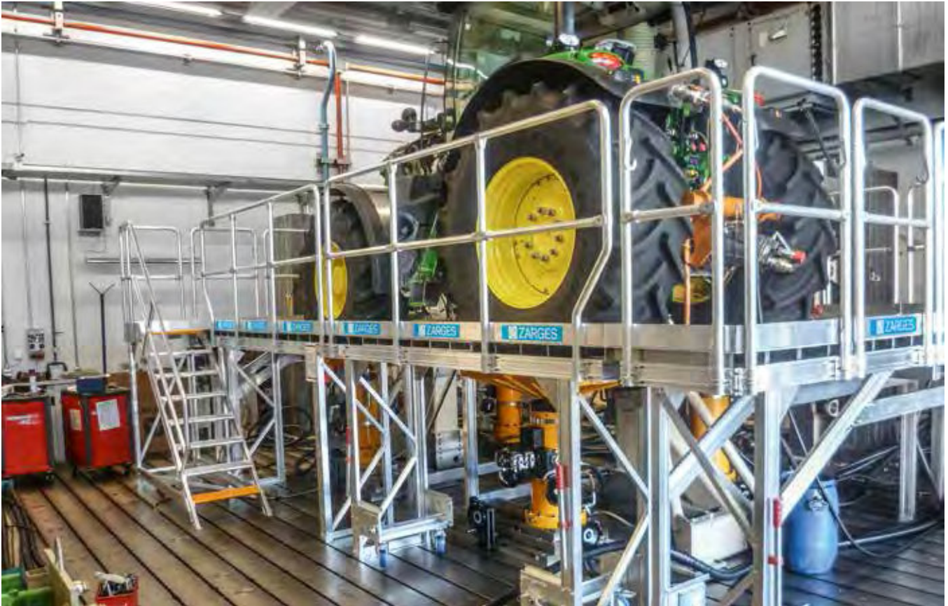
Arbeitsbühne mit Treppenzugang
