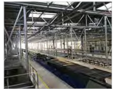
Dacharbeitsstand mit ca. 600m Länge inkl. Materialaufzüge, Krananlagen und PSA
