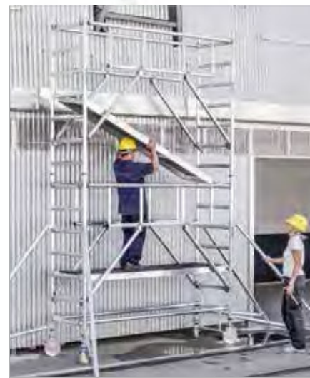
3. Plattform von gesicherter Position einhängen
