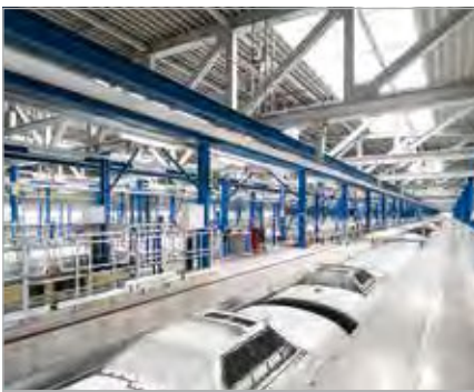
Dacharbeitsstand mit ca. 1.300 m Länge für 3 Gleise
