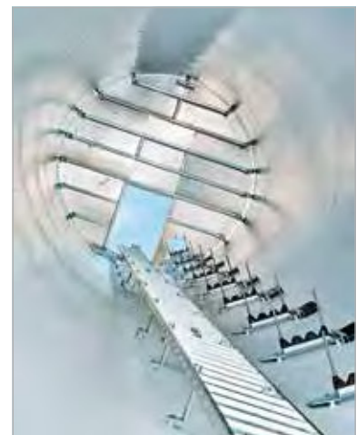
Aufstiegsleiter und Plattform
