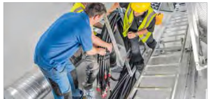
Supervising beim Einbau
