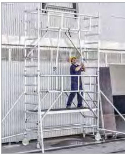
1. Vorlaufendes Geländer einsetzen
