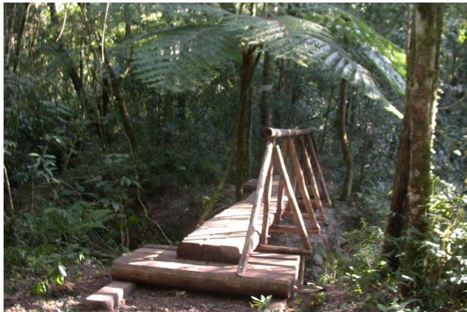
Figura 5.1.4.2. Vista da ponte para pedestres, em direção à parcela na trilha para a parcela permanente, na Estação Ecológica dos Caetetus.
