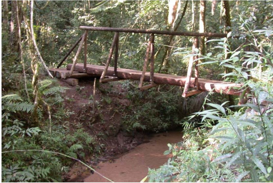
Figura 5.1.4.1. Ponte para pedestres, sobre o Córrego Barreiro na trilha para a parcela permanente, na Estação Ecológica dos Caetetus.
