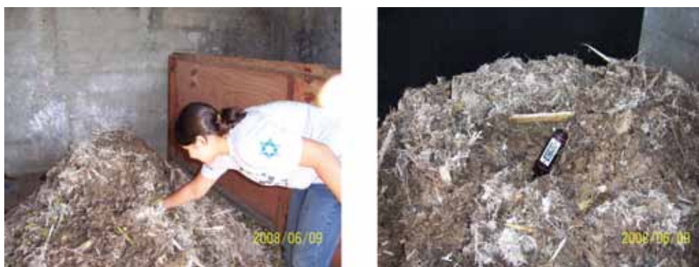
Figura 7 - Monitoramento das pilhas de compostagem (medições de temperatura).
