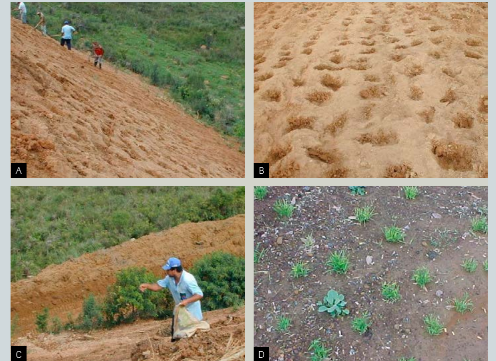
Figura 28: Abertura das covetas com enxada (A), covetas com espaçamento médio de 30 cm (B), semeadura (C) e emergência das espécies de adubo verde (D).
