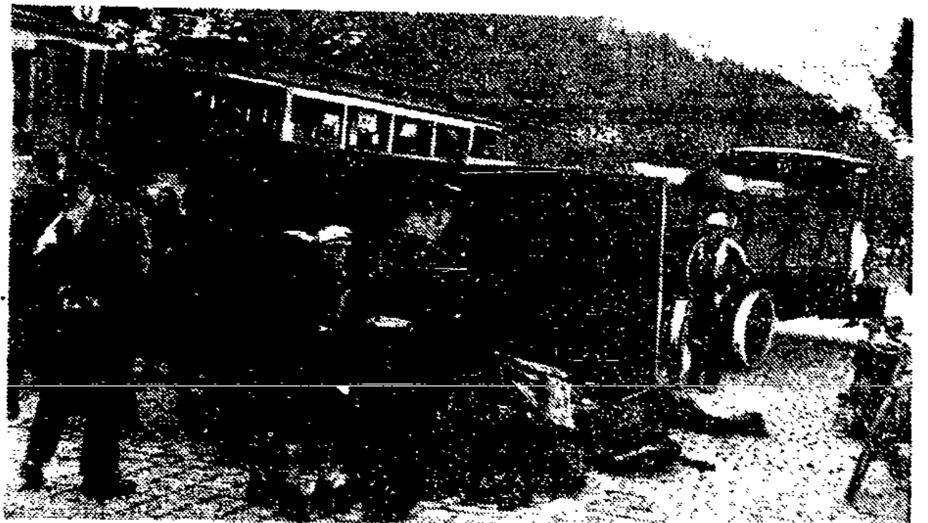
Autoanhänger vom vorderen Fahrgestell glatt abgerissen und auf die Seite gekippt wurde. Außer dem Fahrer, einigen Hautabwürgungen und blauen Flecken wurden Personen nicht verletzt. Die Verkehrshemmung wurde bald beseitigt. Beidezüge konnten mit eigener Kraft weiterfahren.
